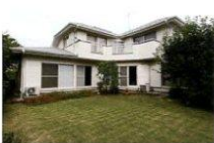
M 邸：塗布箇所/屋根：130㎡、外壁：140㎡。
