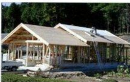
瓦屋根家屋の野地板に塗布。
