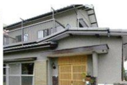
K 邸：塗布箇所/内壁・天井：40㎡、外壁：260㎡。
