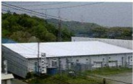
冷蔵倉庫屋根に塗布。
