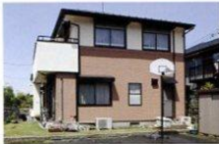
O邸：塗布箇所/屋根：90.9㎡、外壁：156.95㎡。
