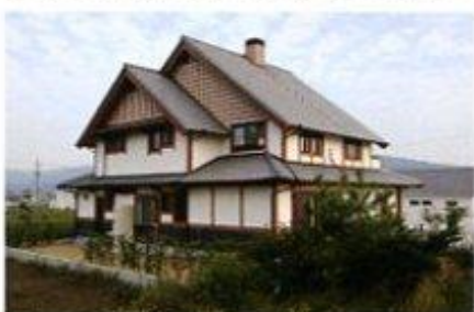
T 邸：塗布箇所/屋根：300㎡、外壁：180㎡他。
