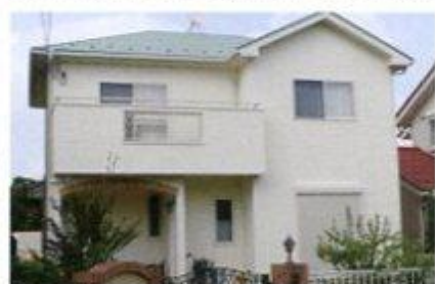
S 邸：塗布箇所/屋根：94㎡、外壁：140㎡。
